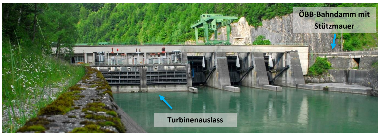
Abb. 8.29: Rechtes Ennsufer mit Stützmauer und Turbinenauslass; linkes Ufer mit Stützmauer und ÖBB-Strecke (Ansicht Unterwasser KW Schönau, Foto: VERBUND)
