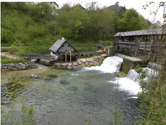
Abb. 2.35: Katzensteinermühle mit FAH am Gaflenzbach
