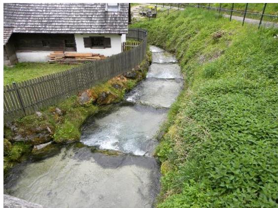
Abb. 2.36: Katzensteinermühle mit FAH am Gaflenzbach ↓
