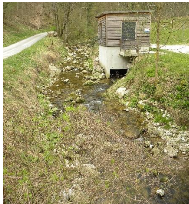
Abb. 2.20: Rückleitung Kleinwasserkraft Rohrgraben ↑
